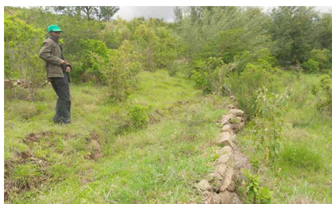
Bassin versant réhabilité au moyen d'excavations de tranchées, de banquettes de pierre et d'enherbement à Miriam Monze, région de Amhara
