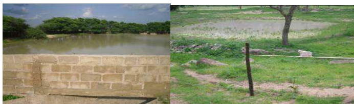
Photo 2. Barrières de contrôle des accès autour des mares
