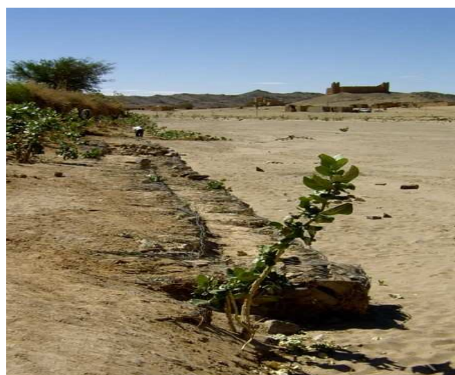
Gabions le long de l'oued à Tinzaouaten - Mali
